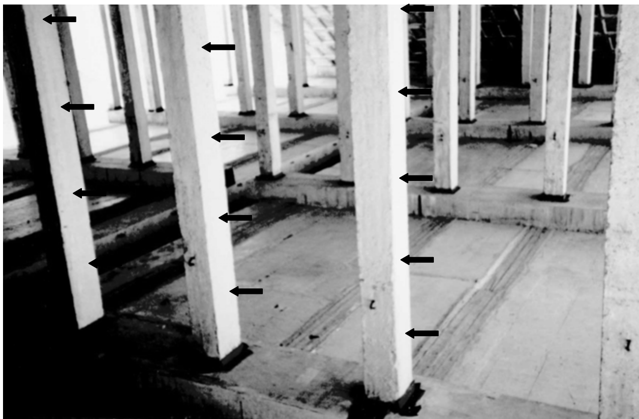
Рис. 3 – Схема расположения точек возбуждения колебаний при вибродиагностике колонн
