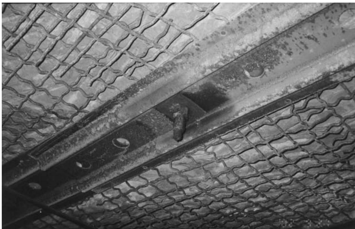
Рис. 1 – Вид кровли горной выработки с установленными анкерами и металлической сеткой-затяжкой
