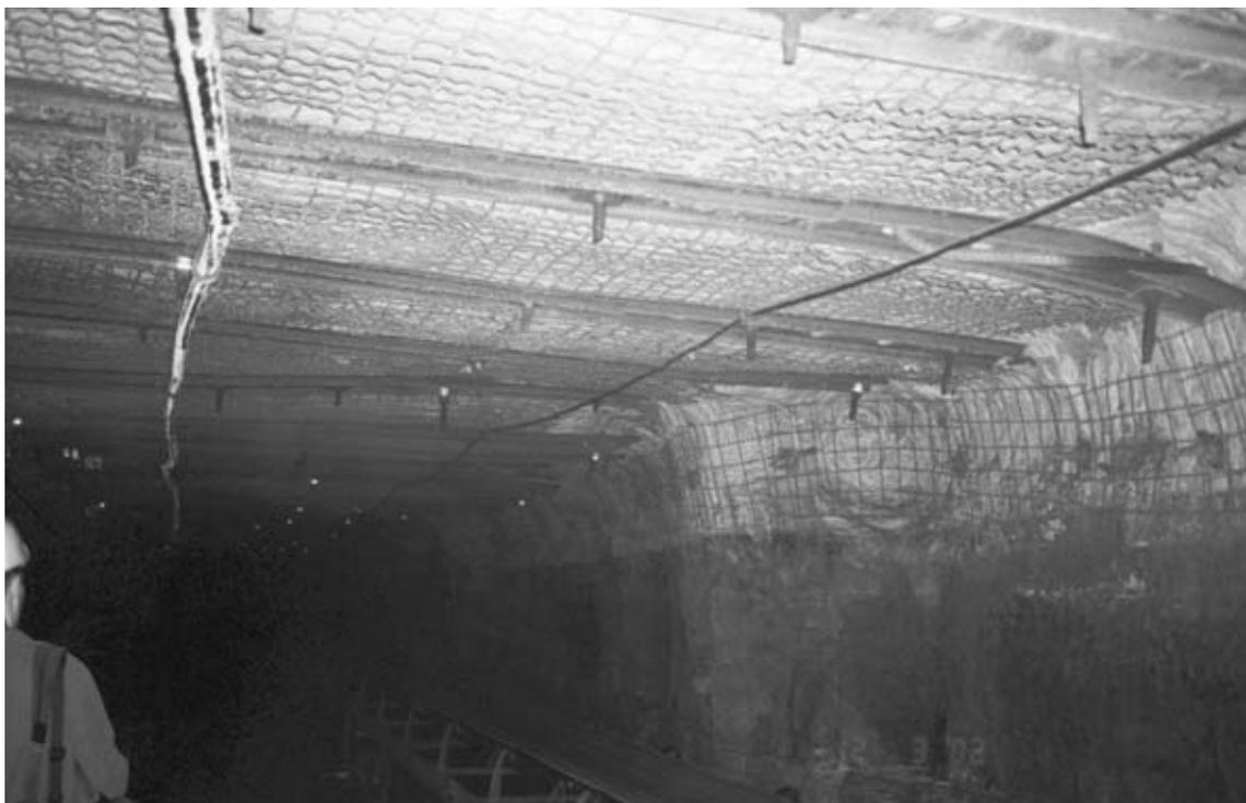
Рис. 3 – Состояние породных поверхностей боков и кровли после 1 года эксплуатации 551 сборного штрека пласта С<sub>5</sub> шахты «Павлоградская»
