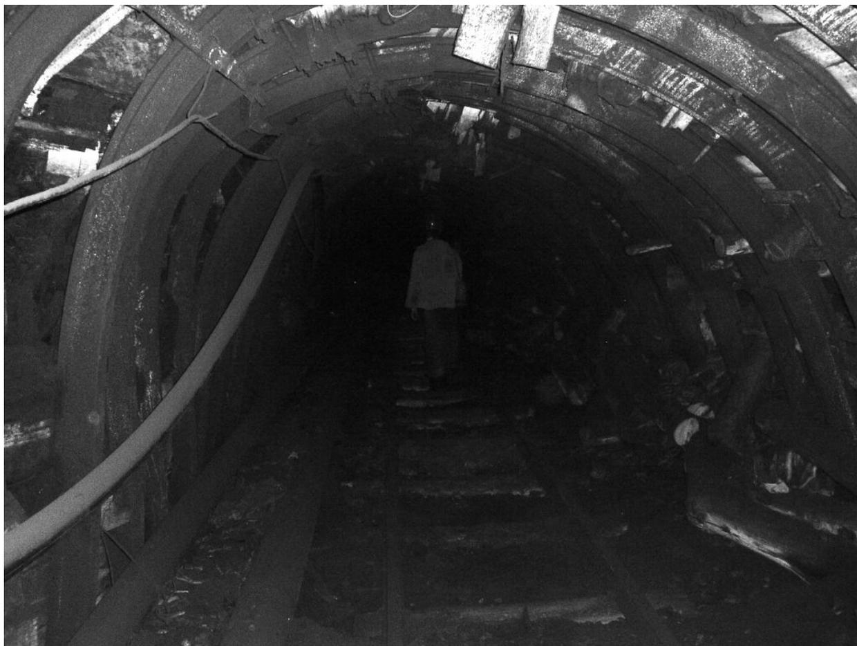
Рис. 6 – Общий вид 870 сборного штрека позади забоя лавы в зоне установившегося горного давления
