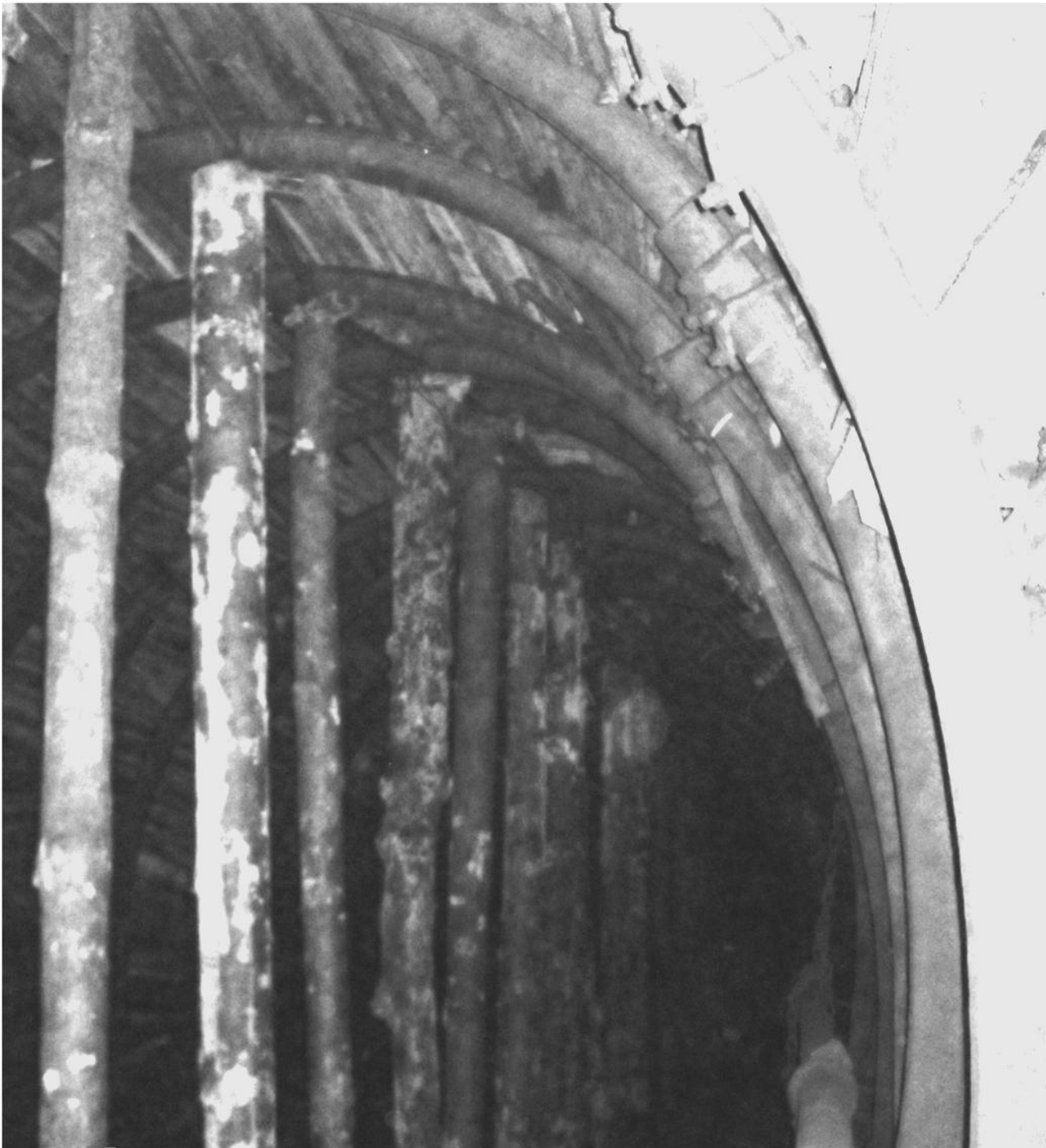
Рис. 5 – Состояние вентиляционного ходка №100 при доработке лавы №102 пласта k_2^1
