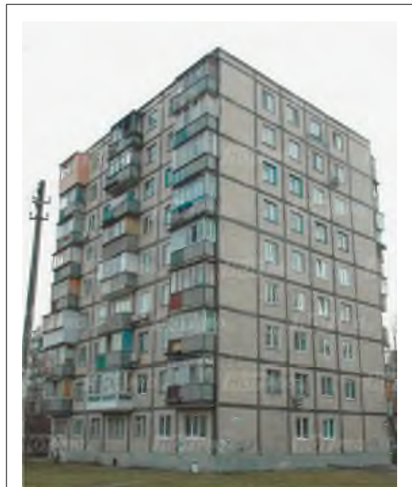
Рис. 1 – Общий вид крупнопанельного жилого дома серии 1-464 АС/ЮБК
